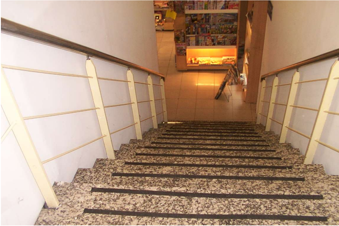
3- Escalera que comunica al sector de baños y teléfonos públicos. Podemos observar barandas en ambos lados y cintas de goma antiresbaladizas en sus escalones, no así solado con relieve, textura y color contrastante.
