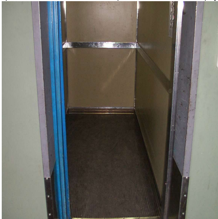
16- Dimensiones del ascensor.
