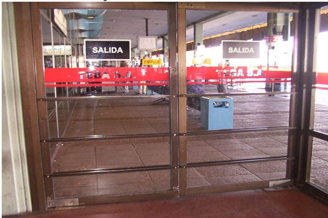
34- Puerta que comunica a las plataformas, tiene barras horizontales para su empuje a diferentes alturas, y franjas en colores contrastantes con letreros del nombre de la empresa y de "salida".
