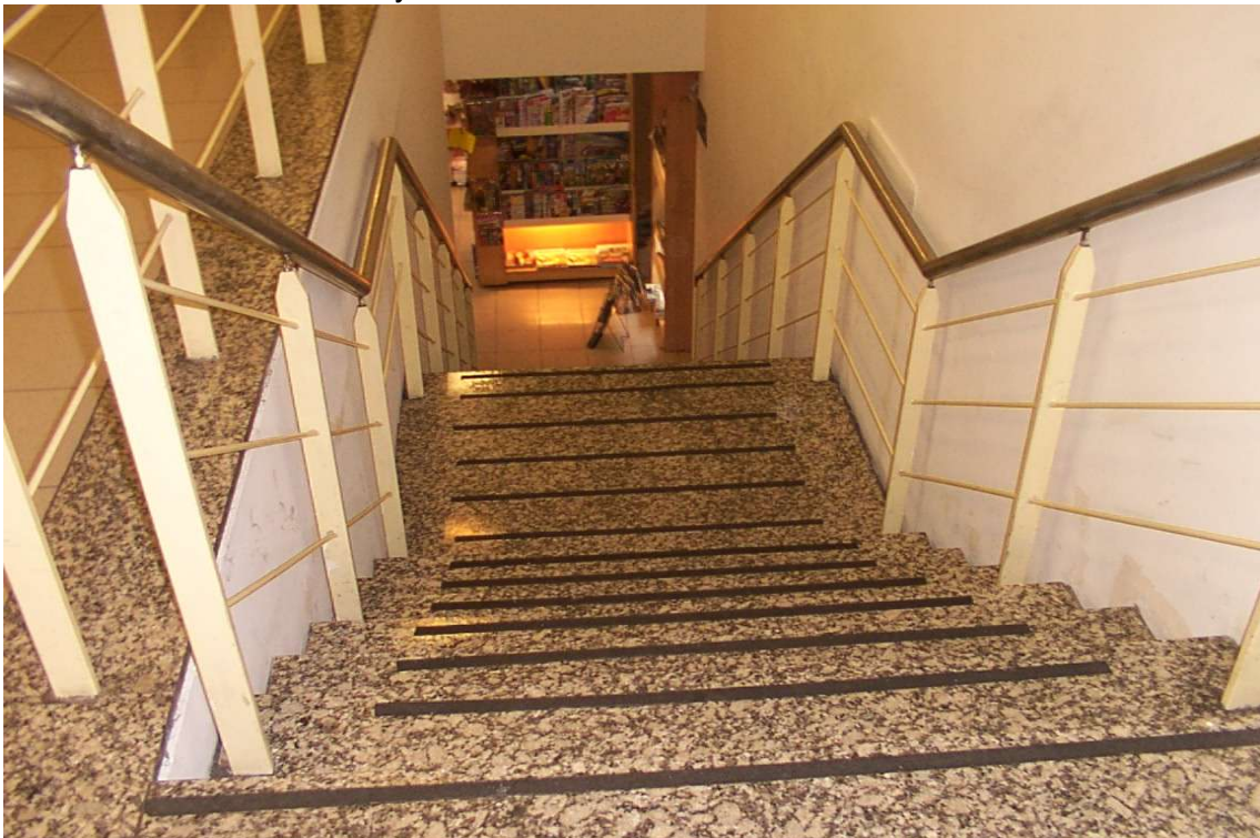
4- Esta imagen muestra el solado de descanso de la escalera , dado cada trece escalones.
