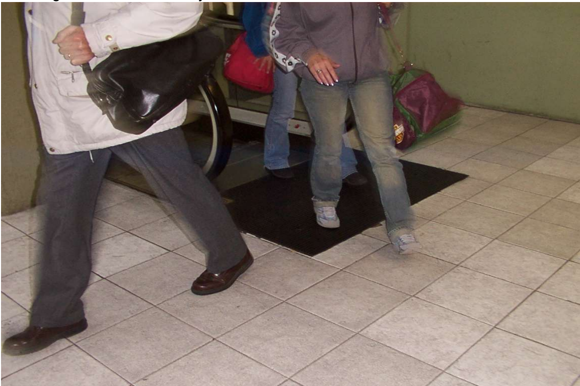
6- Vemos aqui el solado de relieve y color contrastante colocado previo al ascenso a la escalera mecánica.
