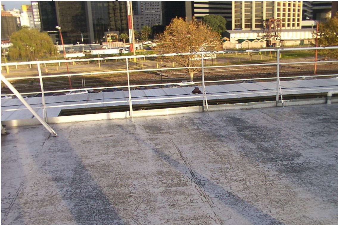
6- Esta baranda se observa en todo el perímetro de la nave.
