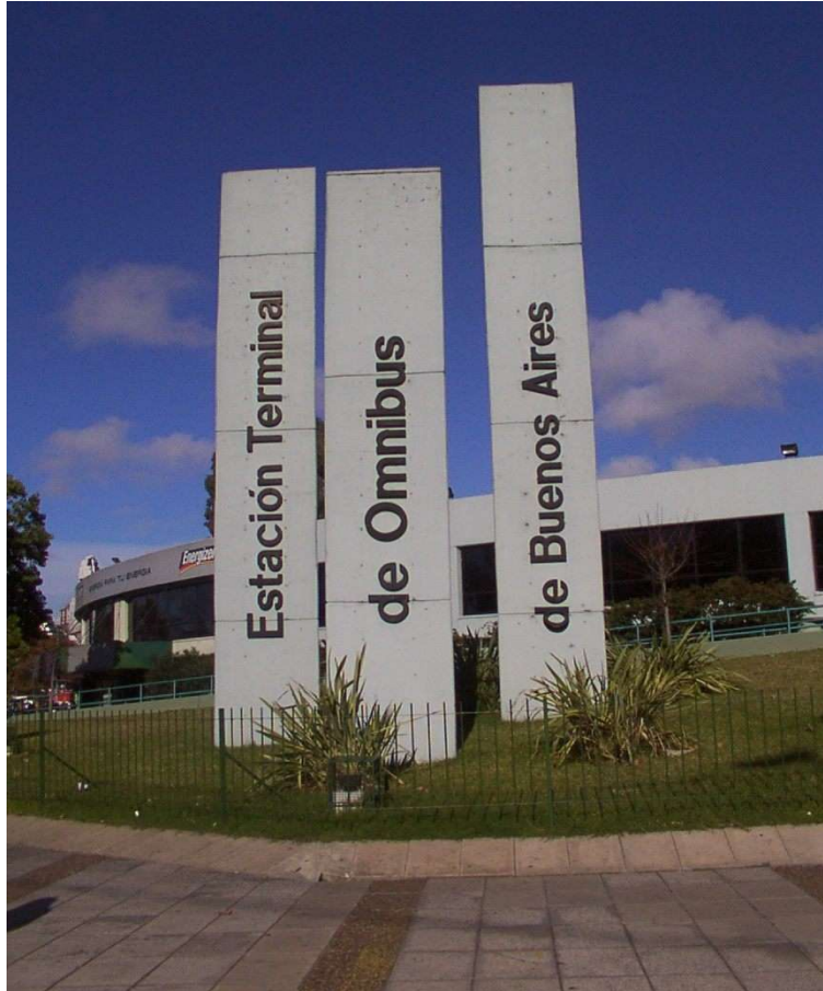
1- Exterior de la Terminal de Ómnibus de Retiro.
