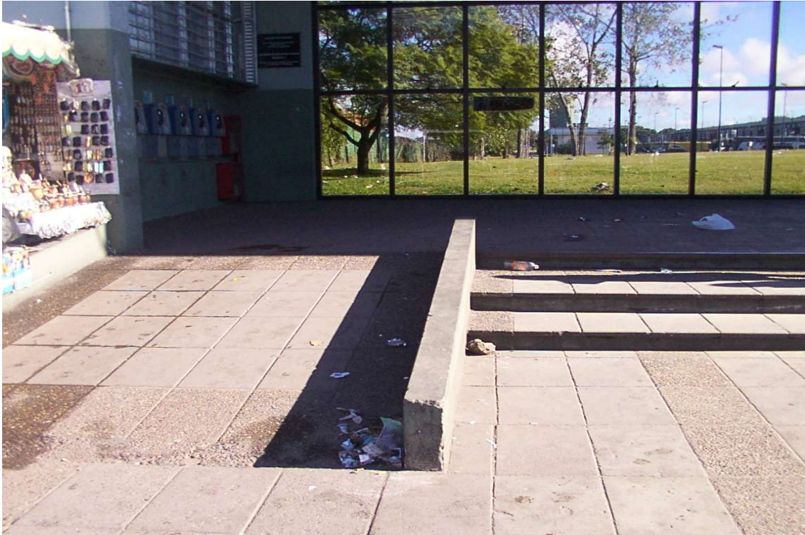
5- Entrada principal con la opción de escalones y rampa.
