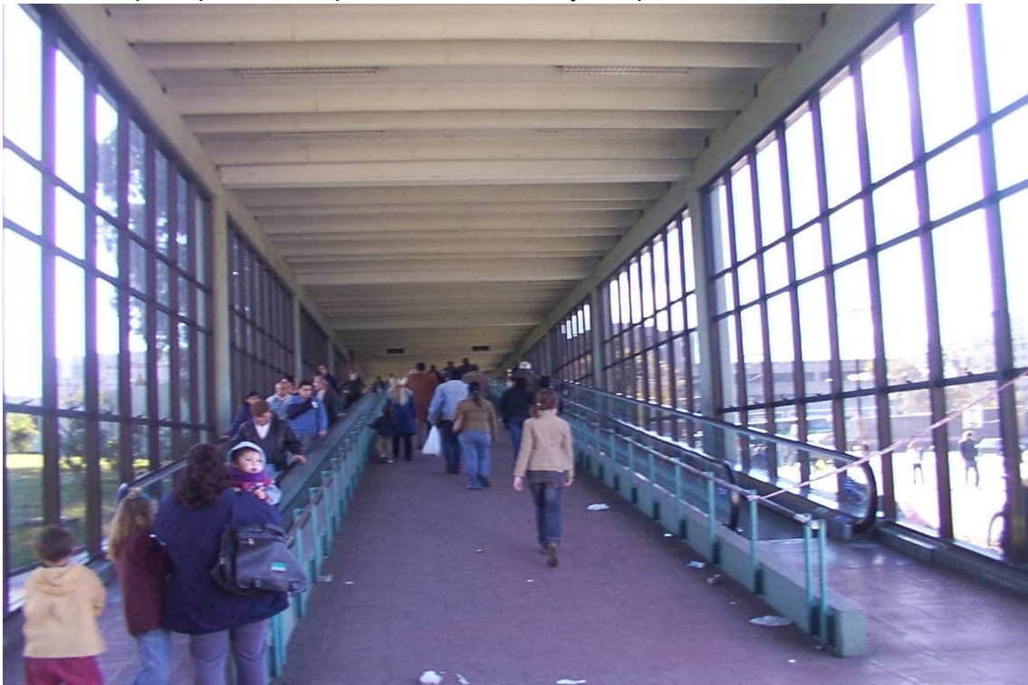
6- El acceso principal, con rampas mecánicas de ascenso y descenso; y una rampa no mecánica. Todas con pasamanos; pero sin pasamanos intermedio en la rampa no mecánica cuyo ancho supera 1,30 metros. Se puede observar también el solado con textura y color contrastante en las rampas mecánicas.
