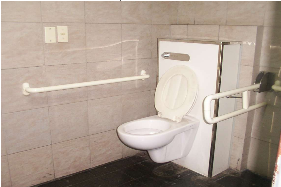
18- Interior del sanitario adaptado en el baño de mujeres, con indoro a menor altura,
